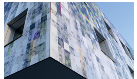
Clientis Park, Schweiz Kubischer Firmensitz mit Mosaikdesign und höchstem Energiestandard. Erdacht von Architektengemeinschaft 4 und Atelier 47.
