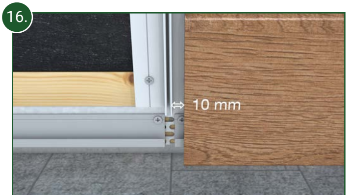
16. Der Dehnabstand zwischen den Enden der Fassadenprofile und den Enden der 2-teiligen Verbindungs-, Abschluss- und Eckprofile sowie des variablen Eckprofils muss jeweils 10 mm pro Seite betragen (siehe Skizze)!
