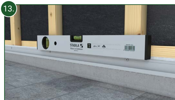
13. Achten Sie bei der Montage des Aluminium-Startprofils bitte auf eine exakte, horizontale Ausrichtung!
